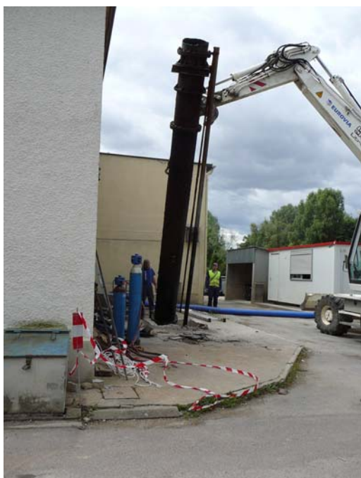
Figure 32 : Extraction et dépose de l'hydraulique de pompage du forage Henri Sellier
