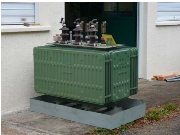
Figure 33 : Dépose de l'ancien transformateur
