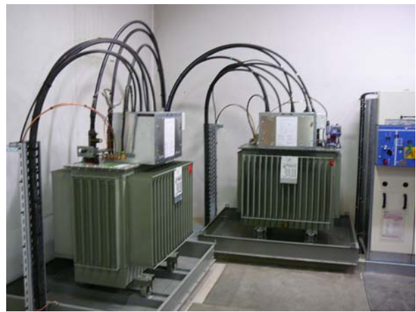
Figure 34 : Implantation des 2 nouveaux transformateurs
